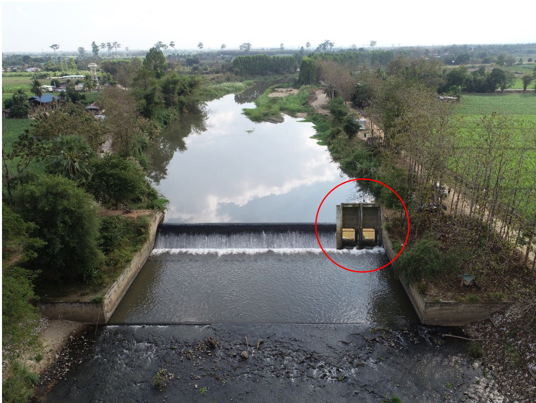
รูปที่ 24 การก่อสร้างประตูระบายทราย (ตัวอย่างฝายหนองปั้งไก่อ)
