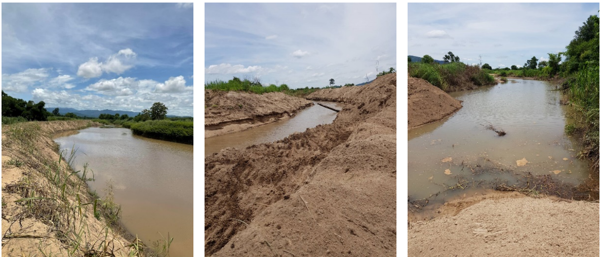
รูปที่ 23 การขุดลอกคลองสวนหมากที่กำลังดำเนินการบริเวณใกล้ประปาหมู่บ้าน
